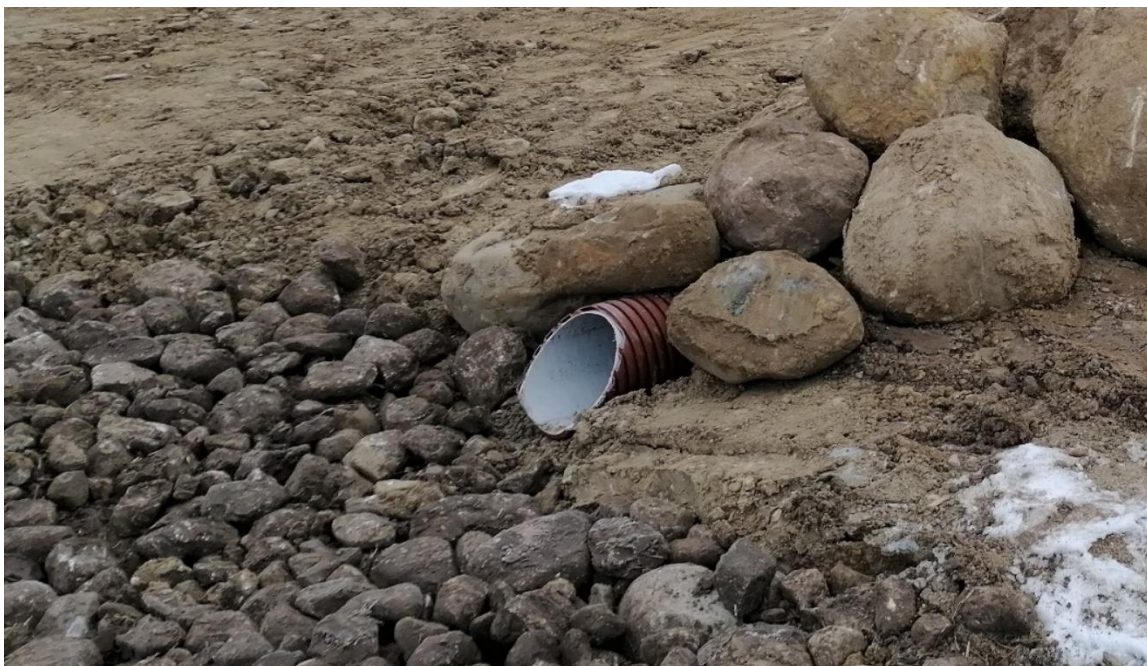
Figur 5-3. Exempel på utformning av utloppet i dammen. Foto: Jonas Johansson
