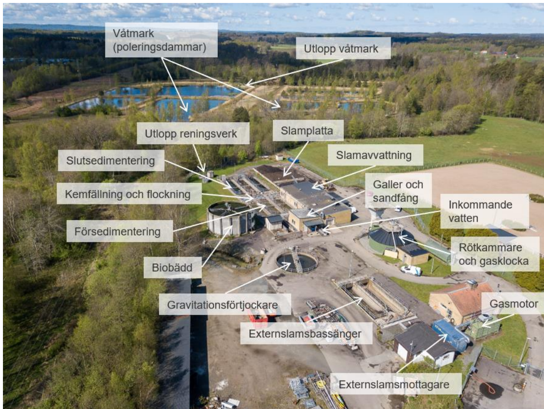
Figur 3. Foto över Perstorp ARV och de olika reningsstegen.
