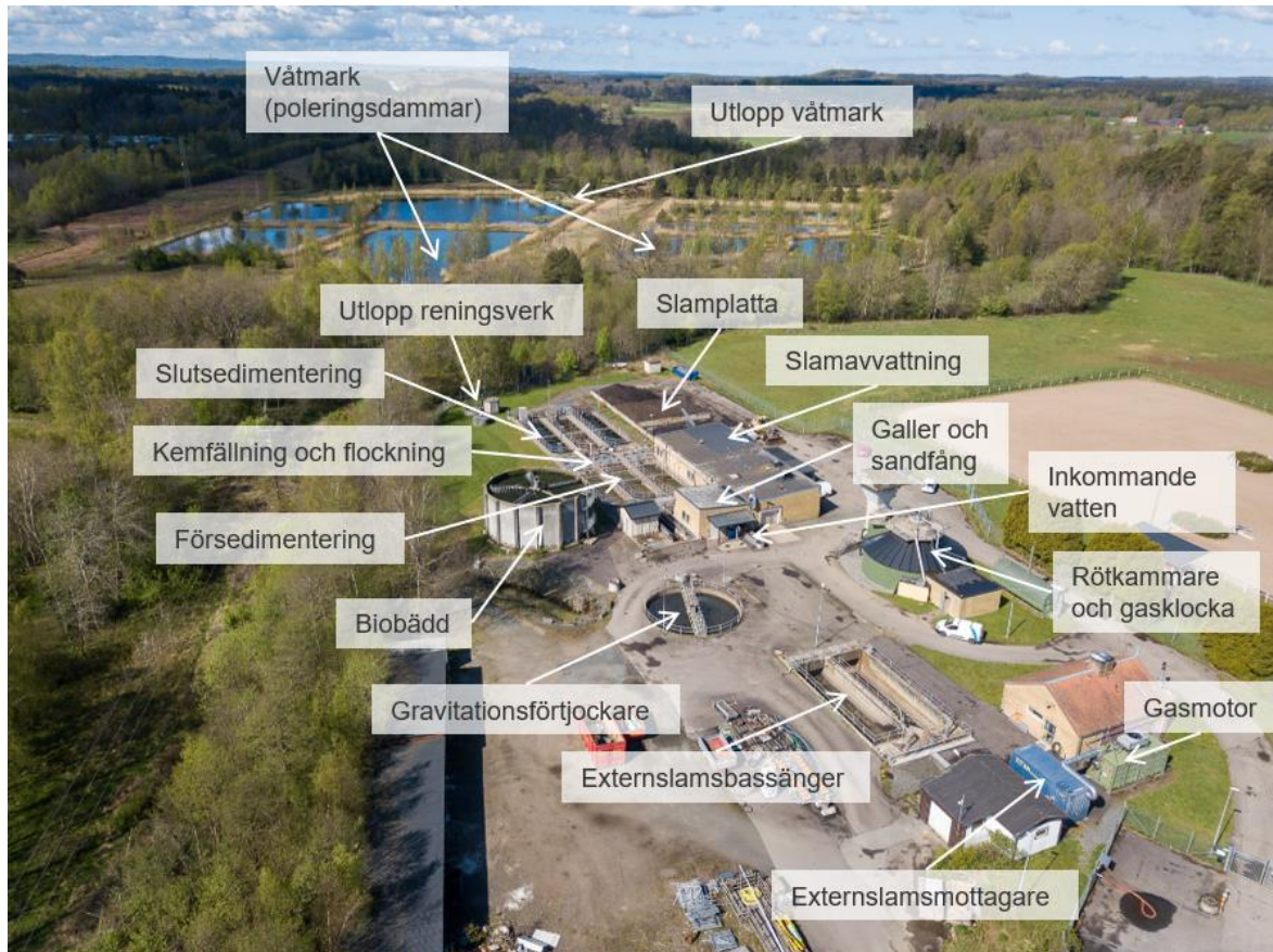
Figur 4. Foto över Perstorp ARV och de olika anläggningsdelarna
