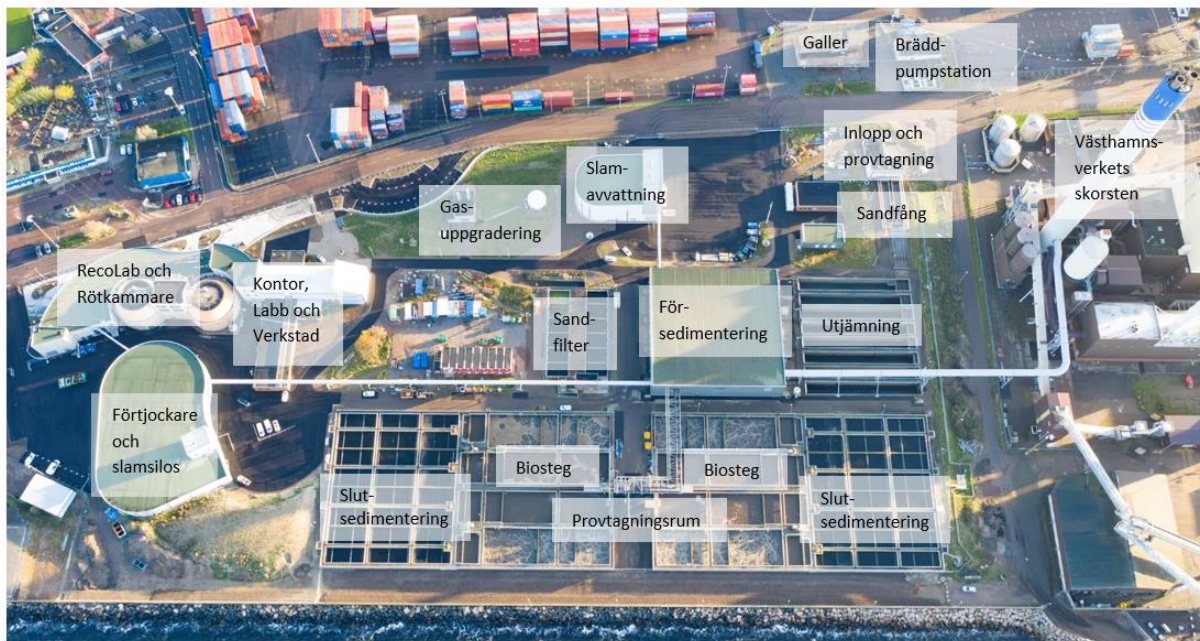
Figur 2. Foto över Öresundsverket och dess olika reningssteg.
